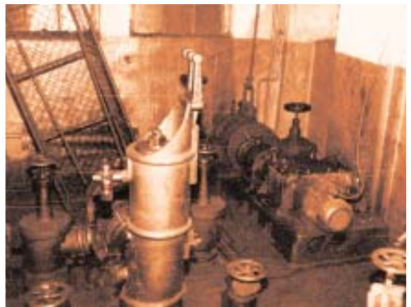
Maszynownia - pompy, 1909 r.
