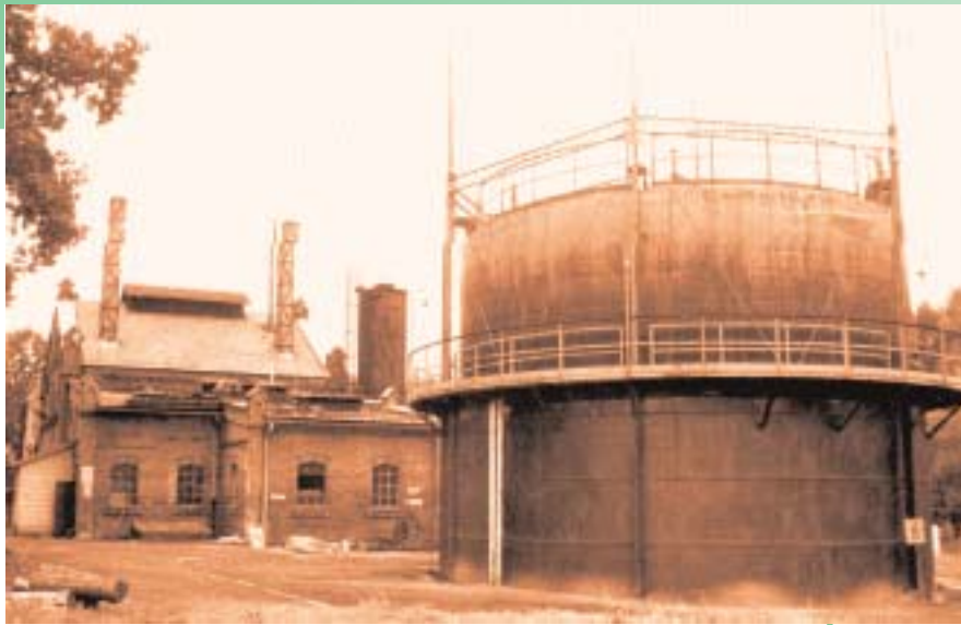
Piecownia (1909) i zbiornik gazu z 1957 r.
