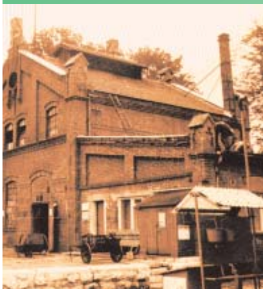
Zespół produkcyjny gazowni z piecownią, 1909 r.
