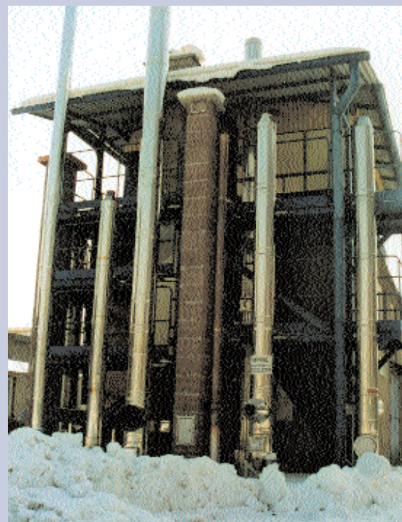
Laboratorium Badań Armatury Instalacji Gazowych i Spalinowych
