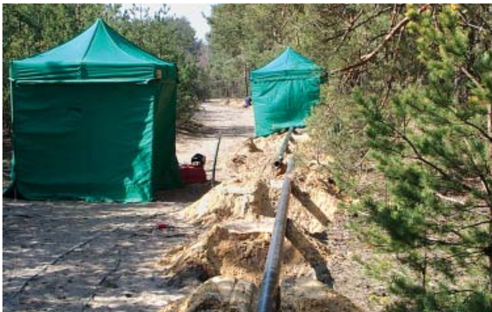
Budowa gazociągu wysokiego ciśnienia
