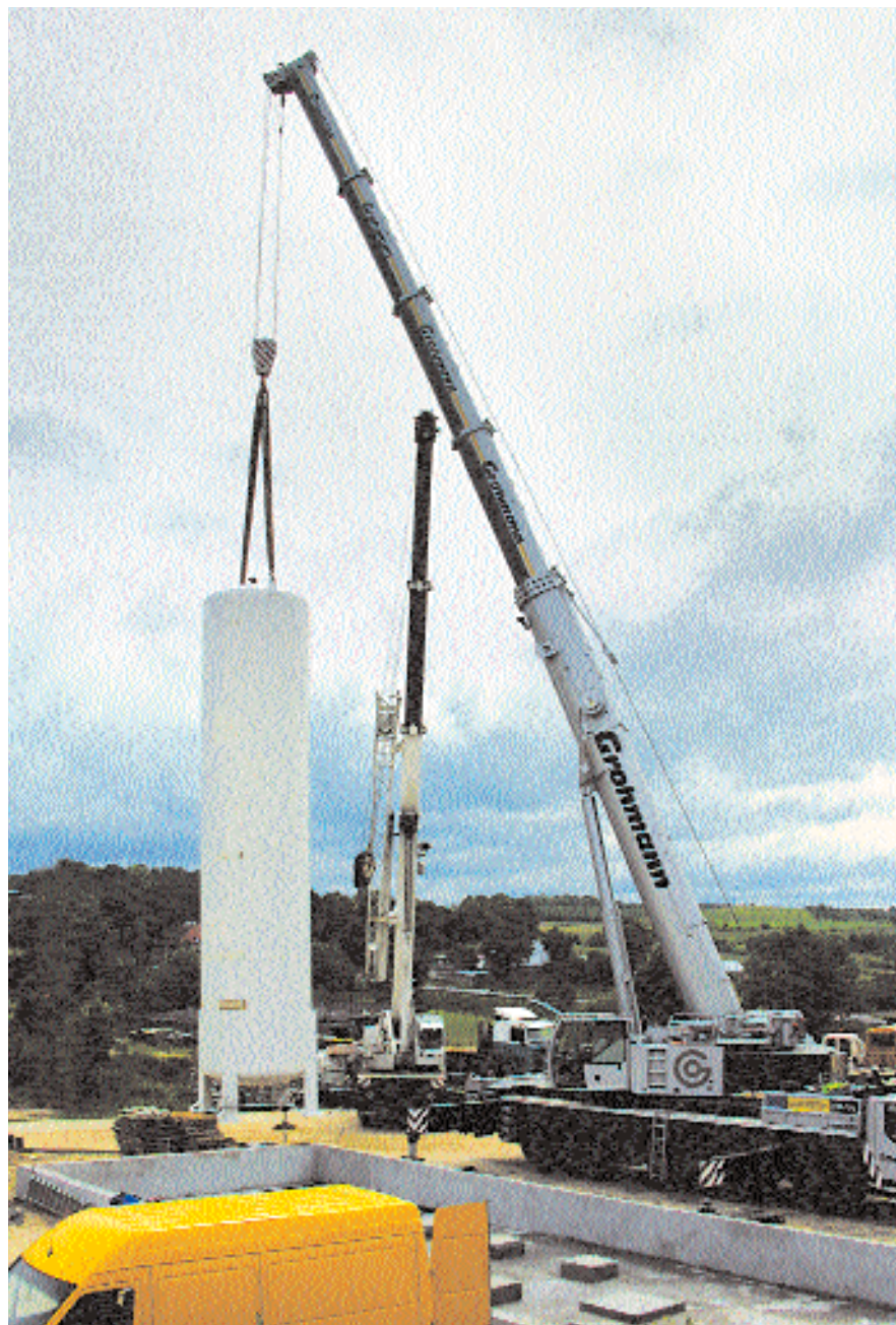
Montaż zbiornika LNG w Miastku
