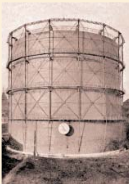
Zbiornik gazu zbudowany w 1926 r.
