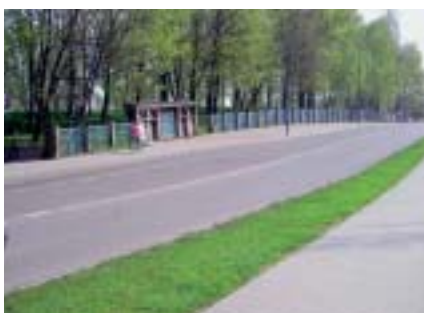
Ogrodzenie i droga w okresie budowy były poziome.
