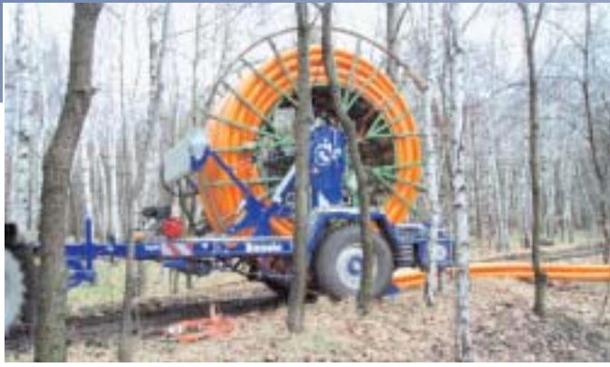
Wózek bębnowy z rurą Compact Pipe.
