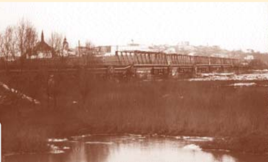
Ogólny widok podwieszenia gazociągu do mostu kołowego na Wiśle w Sandomierzu.
