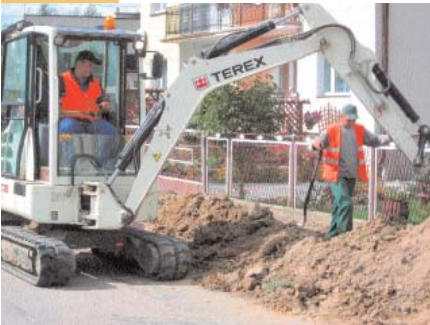
Budowa sieci gazowej w Wyrzysku.
