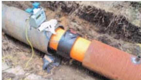
Etap wykonywania podłączeń.
