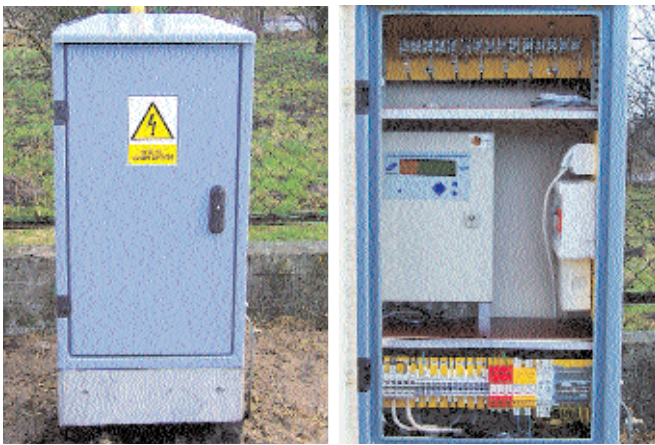
Rys. 2. Urządzenie polaryzujące współczesnej stacji ochrony katodowej
