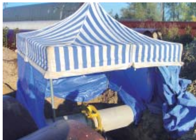
Przygotowanie złącza próbnego do spawania w wykopie.
