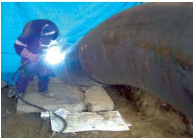
Wykonywanie złączy spawanych w warunkach budowy (warstwa wypełniająca).
