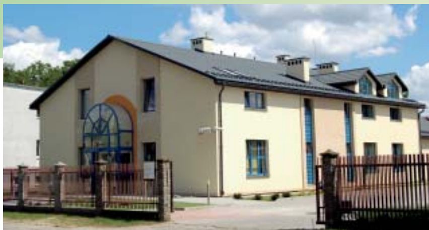
Nowa siedziba RES w Przeworsku.
