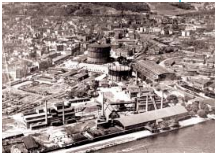
Druga gazownia gdańska po 1935 roku. Widok z lotu ptaka.
