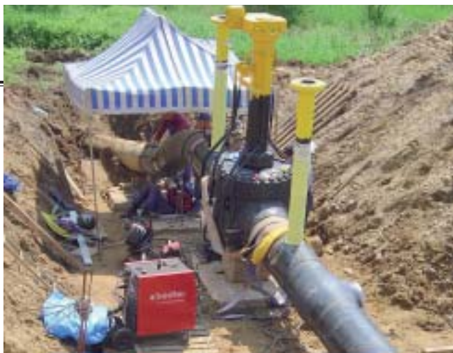
Przygotowanie rur do spawania w wykopie (w warunkach budowy).
