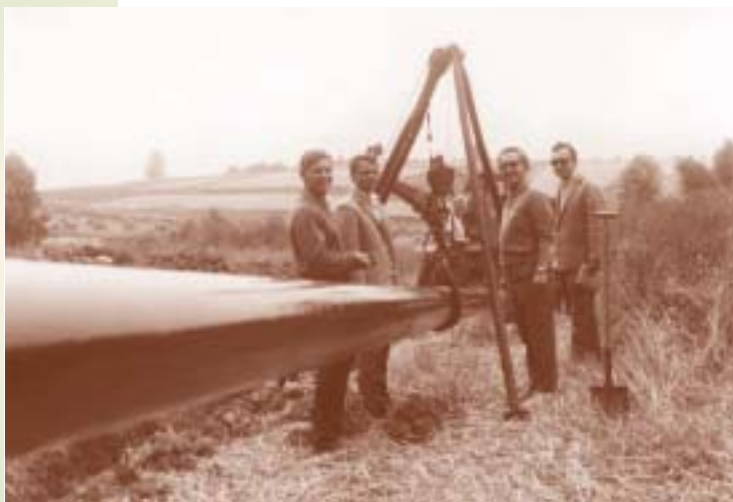
Remont gazociągu, 1970 r.
