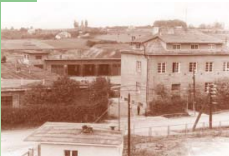
Siedziba Zakładu Gazowniczego w Jaśle, lata 50. ub.w.
