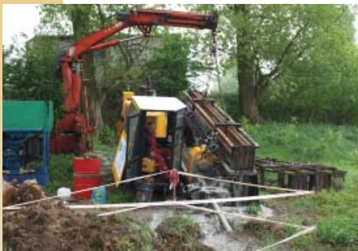
Gazociąg w Koninie – wykonywanie przewiertu pod dnem Warty.
