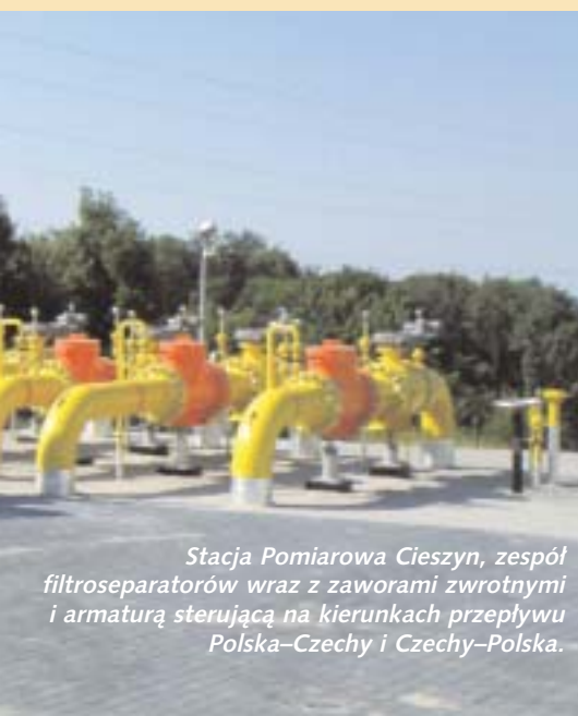
Stacja Pomiarowa Cieszyn w trakcie budowy, instalacja śluzy nadawczo-odbiorczej do tłokowania gazociągu z kierunku Czech.
