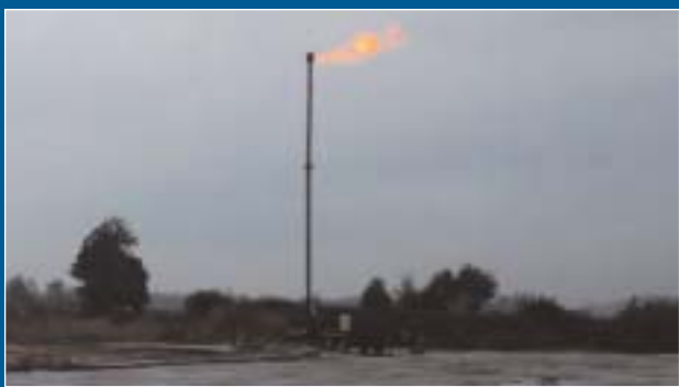
PGNiG SA jako pierwsza polska firma rozpoczęła techniczne wydobywanie gazu z łupków. Przy odwiercie Lubocino-1, na koncesji Wejherowo, nieprzerwanie płonie flara (tzw. świeczka).
