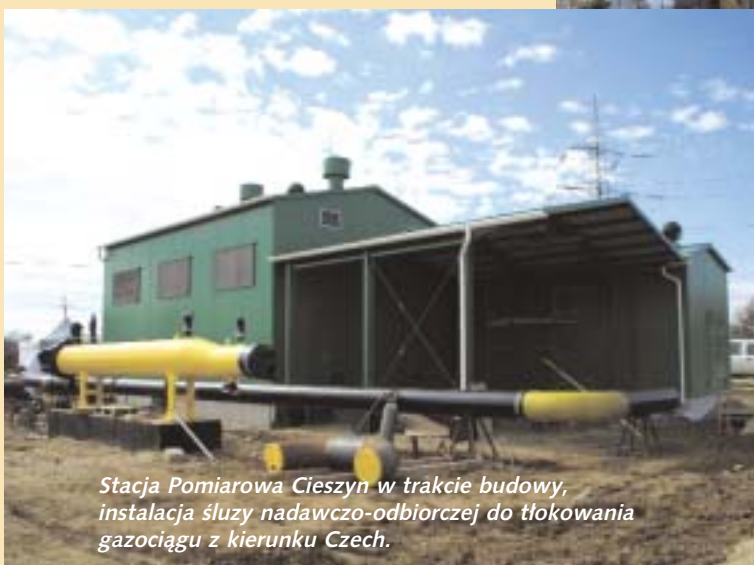
Stacja Pomiarowa Cieszyn, widok śluzy nadawczo-odbiorczej tłoka czyszczącego na gazociągu o średnicy 500 mm.
