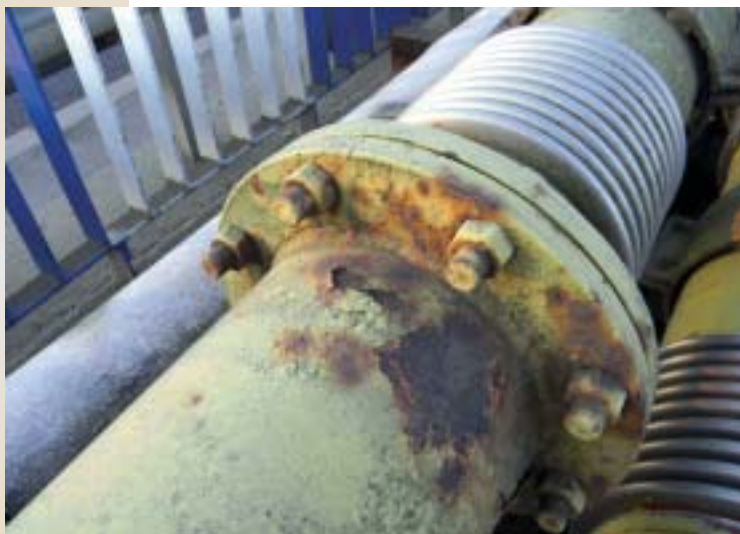
Stan gazociągu przed modernizacją.
