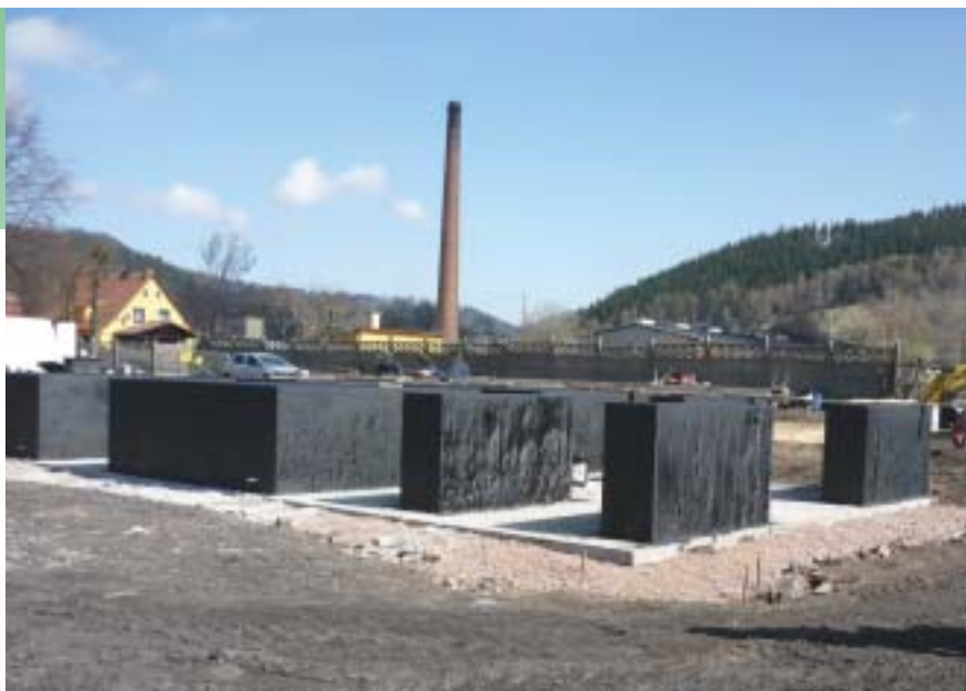
Fundamenty pod parownice produktowe i parownice odbudowy ciśnienia.
