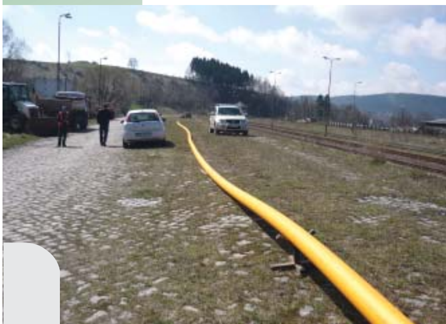
Budowa gazociągu śr/c De160.
