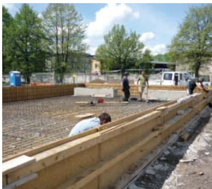
Fundament pod zbiorniki magazynowe kriogeniczne.
