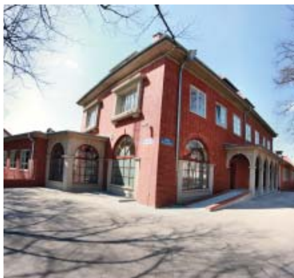
Zmodernizowana siedziba RDG Szczecin Północ.
