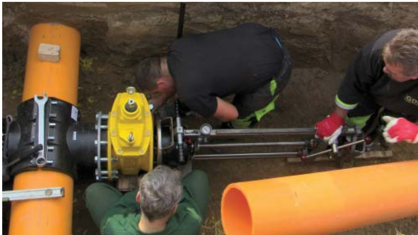
Nawiercanie otworu w czynnym gazociągu DN 315 PE poprzez otwartą zasuwę DN 250 zamontowaną na dogrzanym siodle rozgałęzonym DN 315/250 PE.
