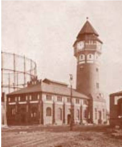
Wieża ciśnieni (gazownia na Tarnogaju).
