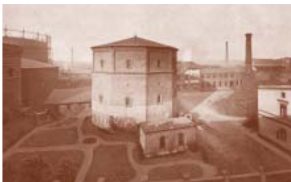
Zakład przy ulicy Tęczowej.
