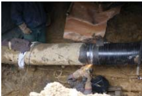
Spawanie fragmentu nowego gazociągu wciągniętego po trasie przewiertu sterowanego ze starą częścią gazociągu.
