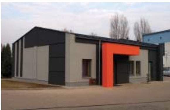
Zmodernizowany budynek Działu Transportu Gazu ZG w Kaliszu.
