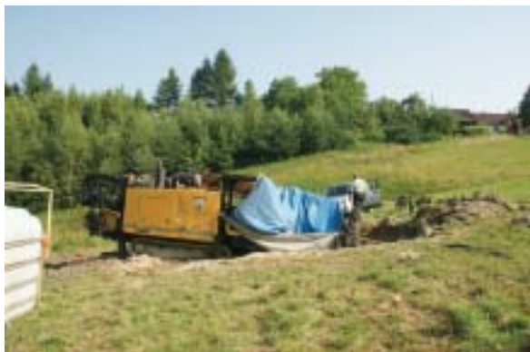
Wykonywanie przewiertu sterowanego na trasie gazociągu.
