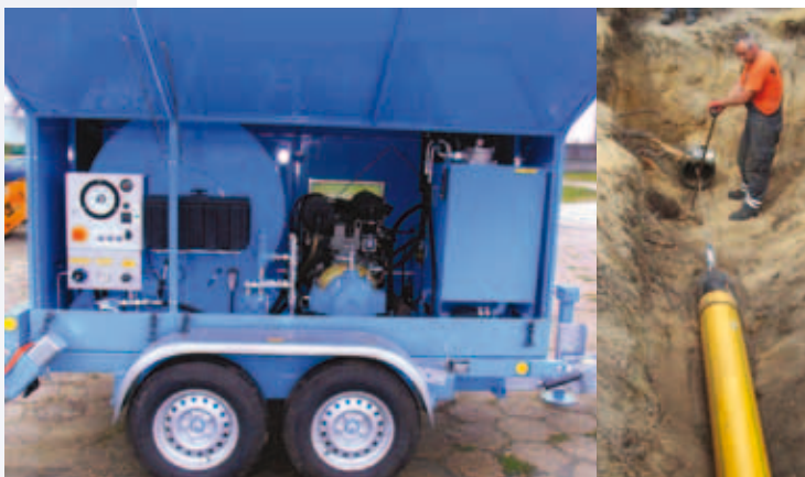
Fot. 1. Wciągarka liniowa do rur PE – relining.
