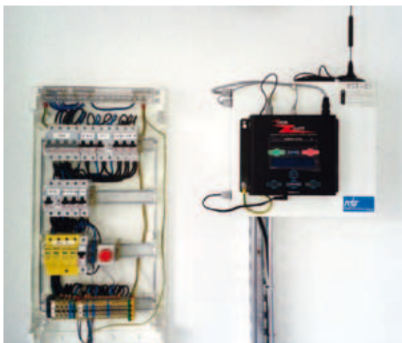
Na zdjęciu przedstawiono instalację systemu ostrzegania przed burzami na stacji gazowej na przykładzie systemu Thor Guard.
