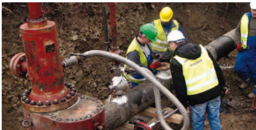
Fot. 2. Stopowanie hermetyczne przepływu gazu z wykorzystaniem technologii T.D. Williamson.
