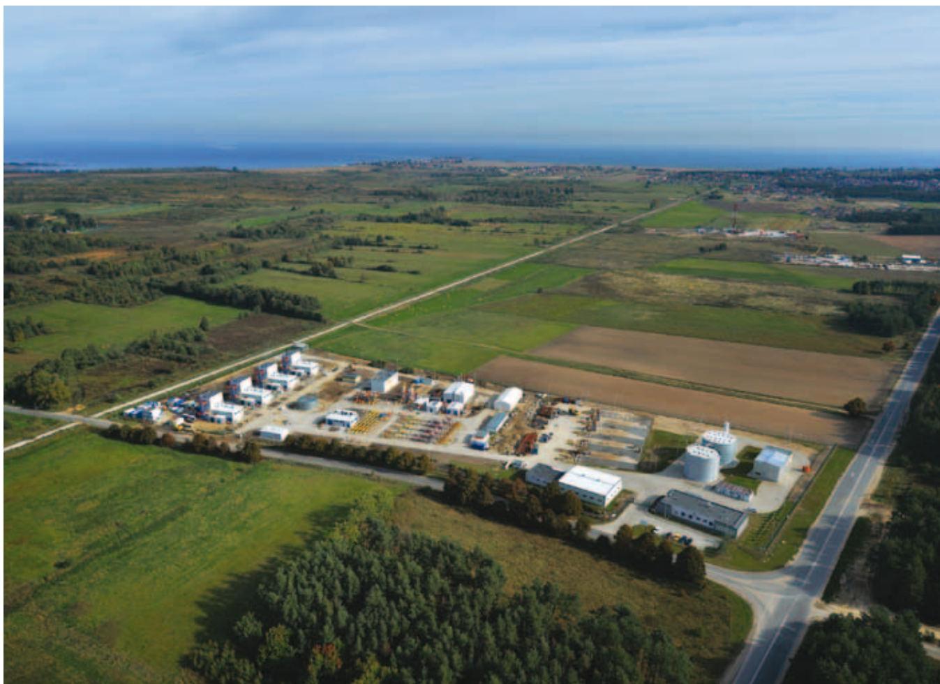
Kawernowy Podziemny Magazyn Gazu Kosakowo z lotu ptaka.
