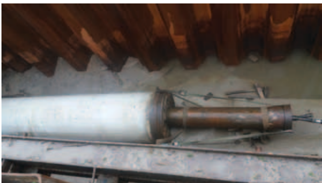
Przecisk rurą stalową.
