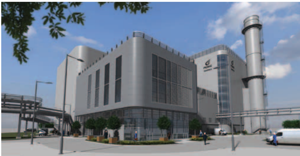
Wizualizacja budowanego przez PGNiG Termika SA bloku gazowo-parowego w Elektrociepłowni Żerań w Warszawie.
