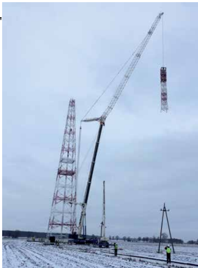
Demontaż wieży w ZZU Radojewice Fot. archiwum EuRoPol GAZ s.a.
