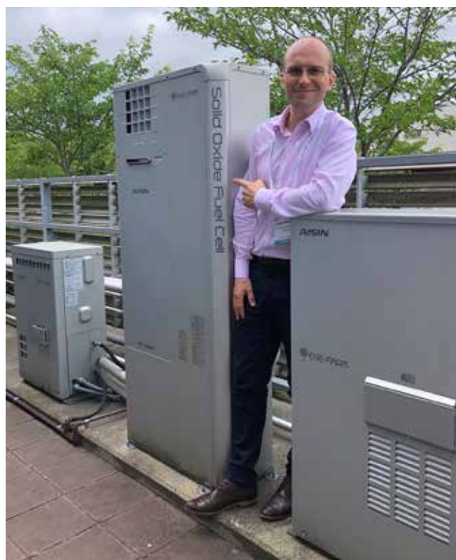
Rysunek 2. Najnowsza generacja układów ENE-FARM Type S firmy AISIN o mocy 700 W i sprawności elektrycznej 52%.
