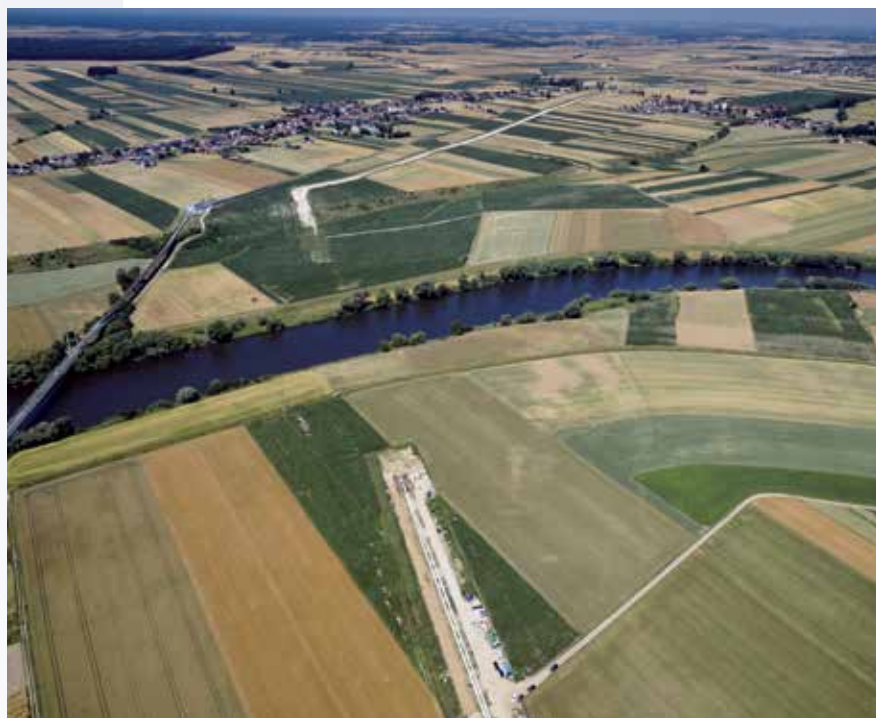
Budowa gazociągu Zdieszowice–Wrocław: przejście pod Odrą w Kątach Opolskich.
