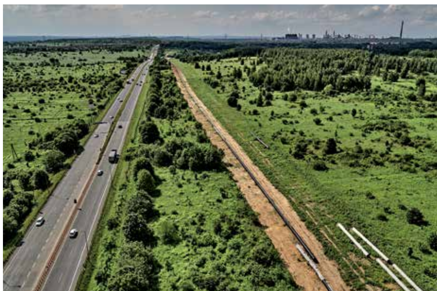
Budowa gazociągu Pogórska Wola-Tworzeń. Po lewej droga krajowa nr 94, po prawej kominy huty, a w środku międzynarodowa magistrala – Korytarz Północ-Południe.
