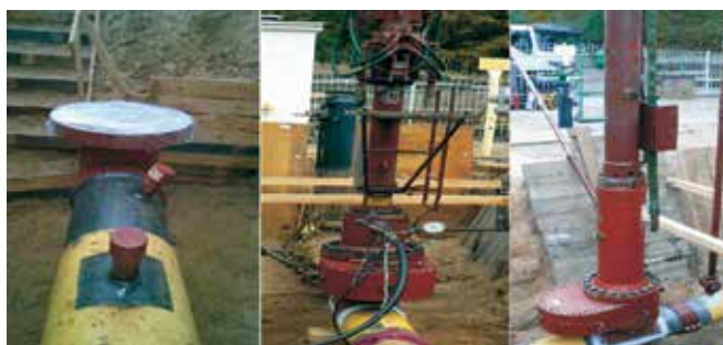
Zestaw kształtek, zestaw do nawiercania i zestaw do wstrzymania przepływu.
