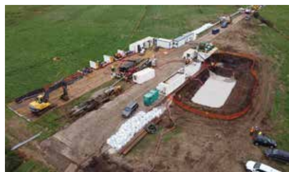
Plac HDD od strony rurowej. Fot. HDI S.A.S.
