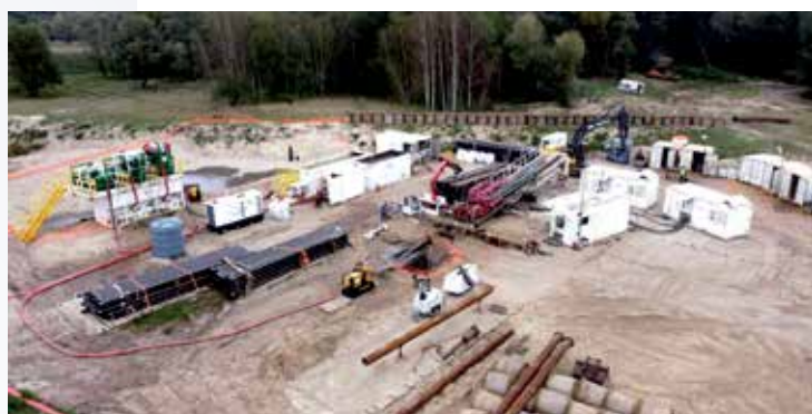
Plac HDD od strony maszynowej. Fot. HDI S.A.S.
