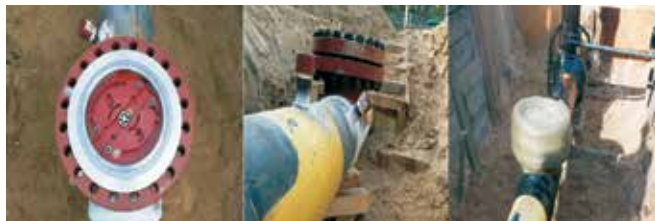
Zakorkowane i zaizolowanie kształtki.
