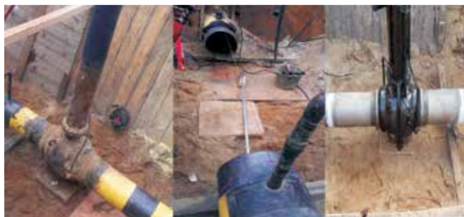
Zawór do wymiany, miejsce po demontażu uszkodzonego zaworu, nowo zabudowana armatura.
