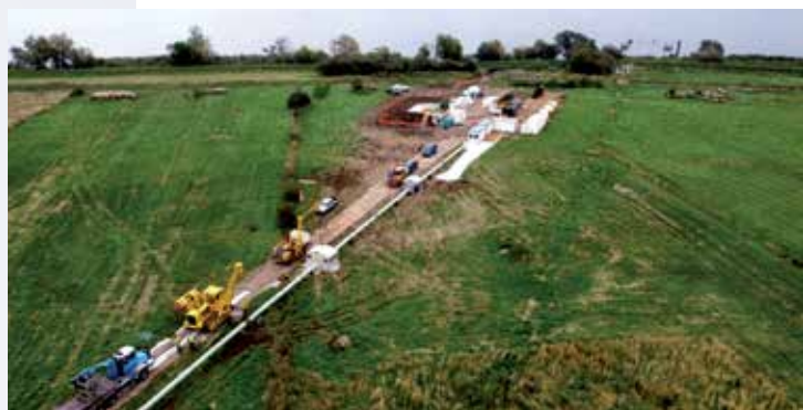
Przygotowanie gazociągu do wciągania. Fot. HDI S.A.S.
