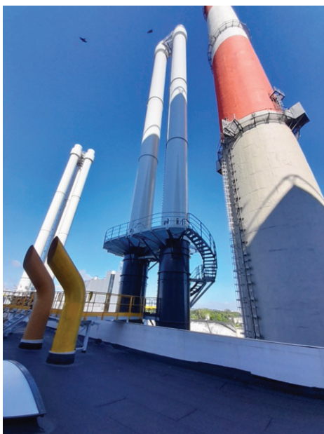
Kominy KG2 w Ec. Żerań widoczne pośrodku.
