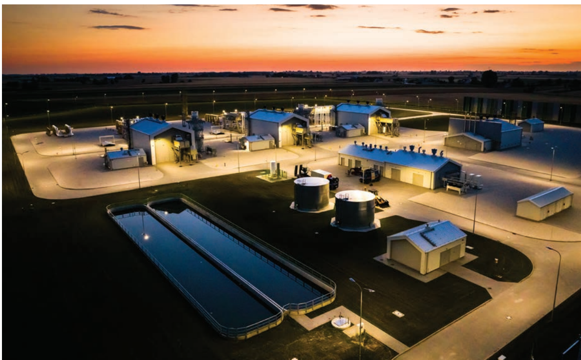
Porozumienie z WOT zwiększa poziom bezpieczeństwa takich obiektów jak tłocznia Gusterzyn.
