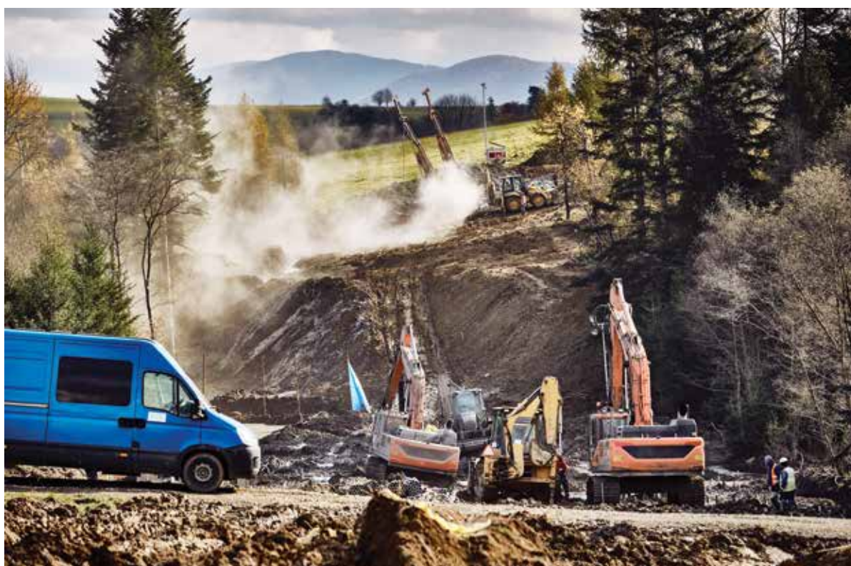
Zamieszczone w artykule zdjęcia pochodzą z budowy gazociągu Strachocina-granica RP.
