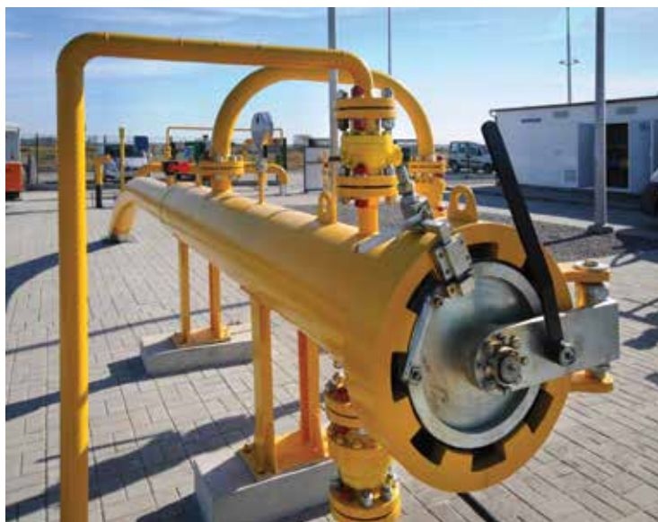
Śluza nadawczo-odbiorcza tłoka inteligentnego.
