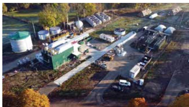
Rysunek 5. Instalacje ułamkowo-techniczne zrealizowane w ramach przedsięwzięcia „Innowacyjna biogazownia” w Brodach na terenie należącym do Uniwersytetu Przyrodniczego w Poznaniu
