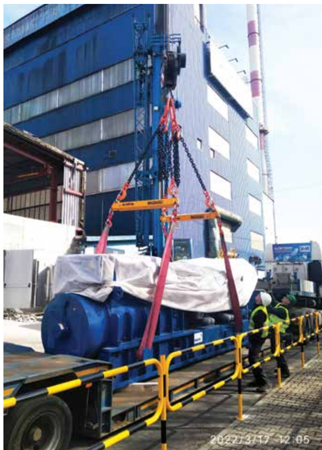
Dostawa-transport silników w Zakładzie Jastrzębie-Zdrój.
