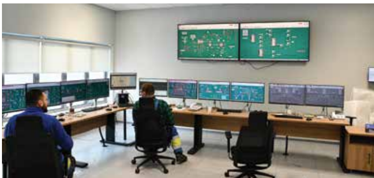
Nowa nastawnia w Ec Pruszków.
