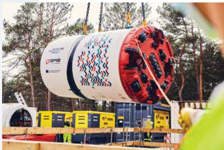
Baltic Pipe – maszyna TBM.
