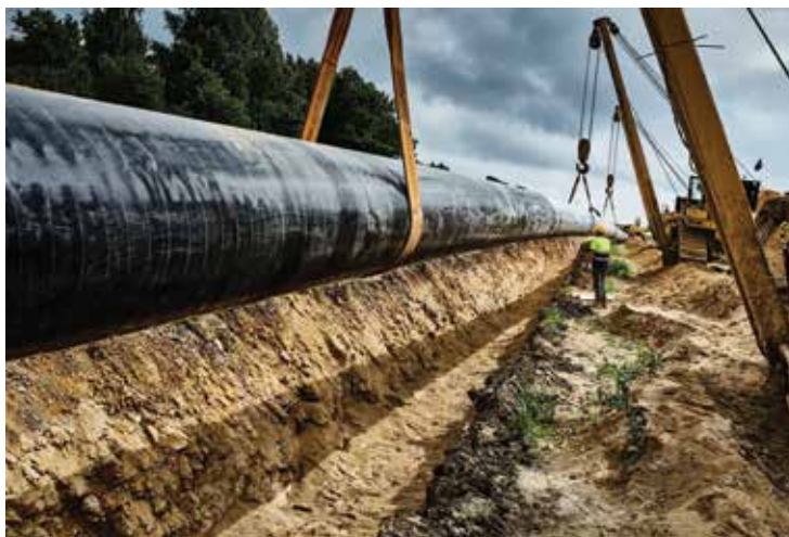
Budowa gazociągu Pogórska Wola–Tworzeń.
