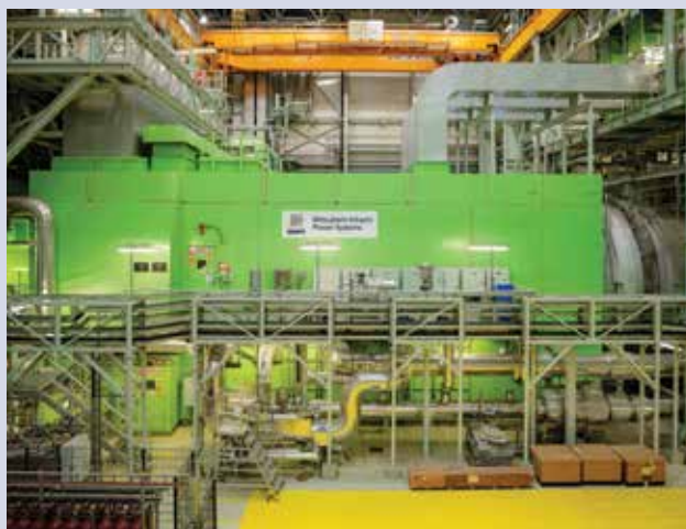
Nowoczesna turbina Mitsubishi zamontowana w bloku gazowo-parowym Ec Żerań może w przyszłości współspalać wodór.
