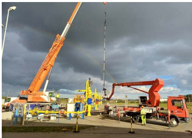
Przygotowanie do pomiarów geofizycznych – montaż śluzы ciśnieniowej.
