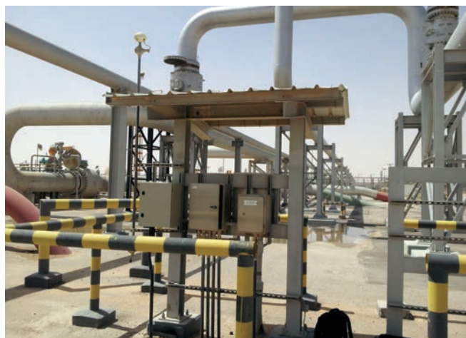
Zastosowanie akustycznego systemu detekcji wycieku ALDS.
