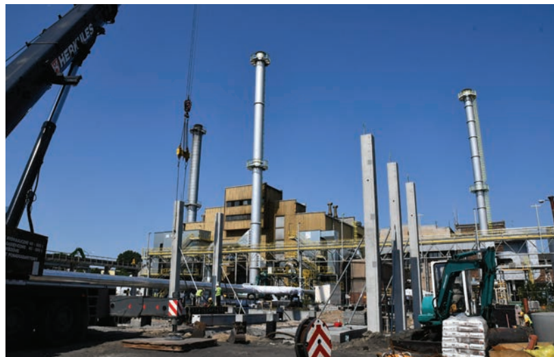
Budowa hali kotłów, widok na fundamenty, gdzie zostaną zamontowane jednostki grzewcze.
