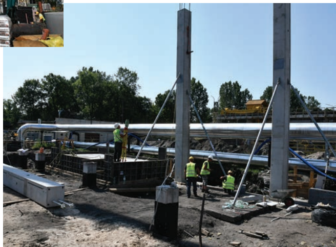
Budowa hali kotłów, widok na fundamenty, gdzie zostaną zamontowane jednostki grzewcze.
