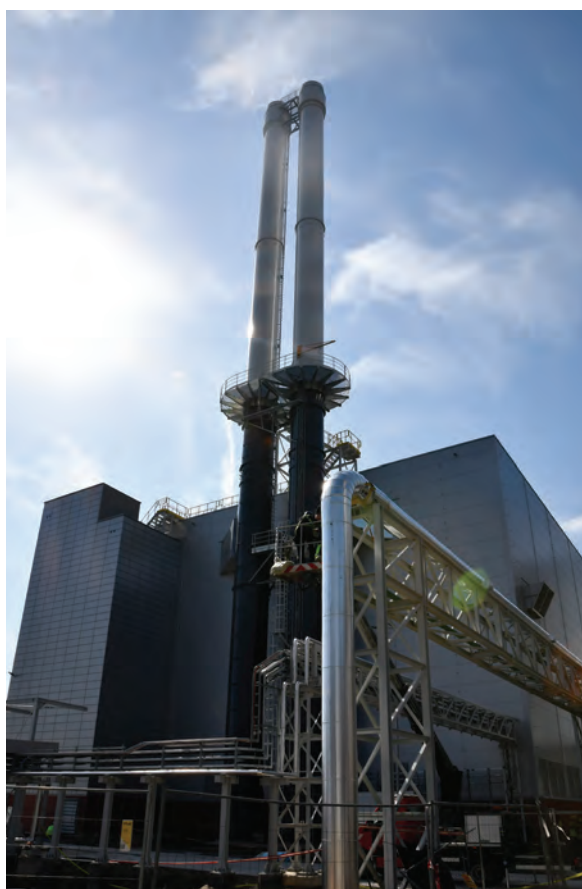
W Ciepłowni Kawęczyn powstaje nowoczesna kotłownia gazowo-olejowa.
