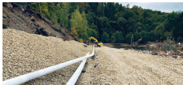
Zabezpieczanie gazociągu DN 300 relacji Ołtaszyn–Kudowa.
