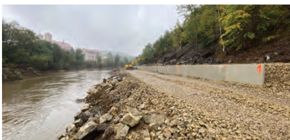
Umocnianie muru oporowego od strony rzeki wzdłuż gazociągu DN 300 relacji Ołtaszyn–Kudowa.
