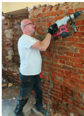
Tomasz Kozieja, PGNiG OD, podczas prac remontowych.
