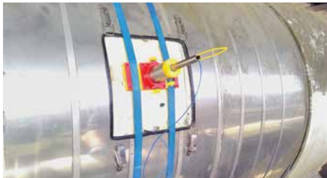
Rysunek 4. Zamontowane głowice do badań metodą emisji akustycznej na instalacji terminalu LNG
